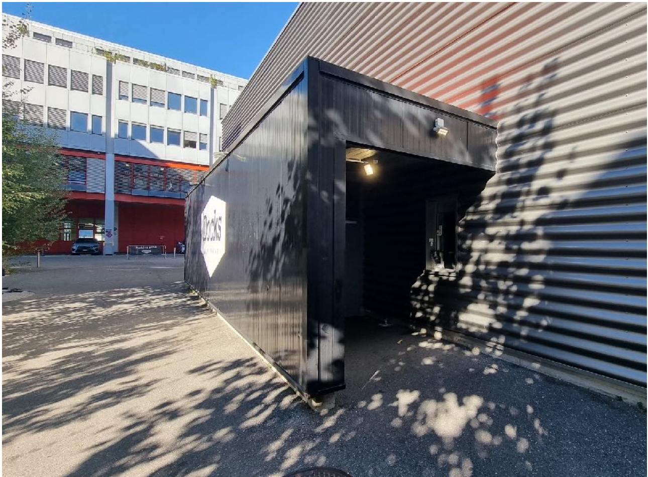
Entrée du bâtiment
